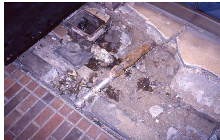
給水管の破損
