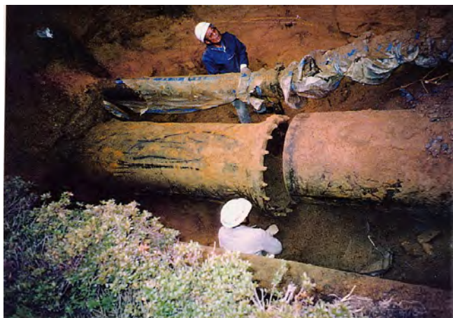
ダクタイル鋳鉄管・継手部の抜け 800mm
