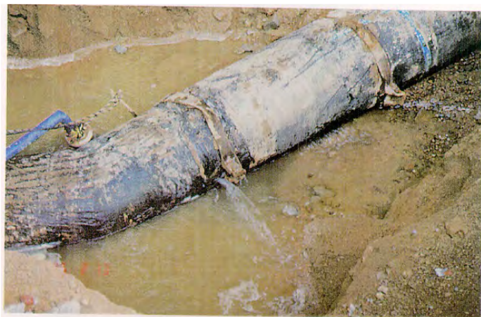
液状化による管体（CIP）被害 600mm
