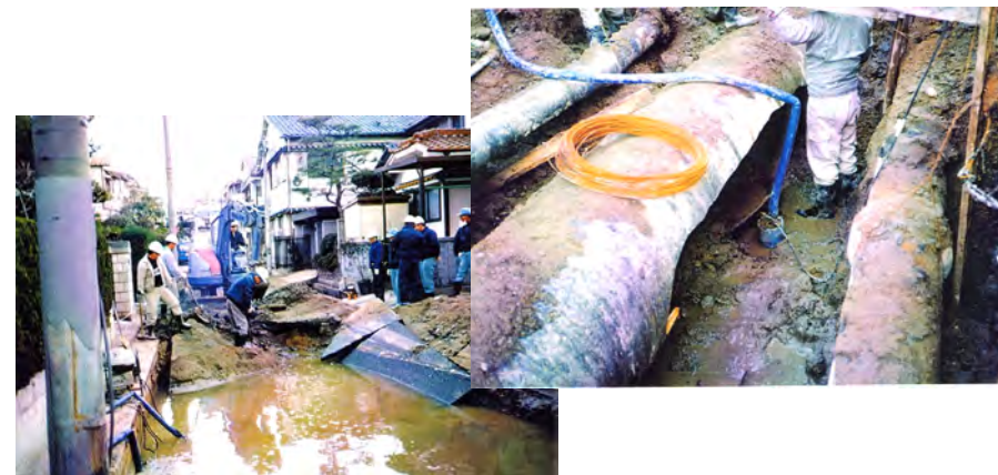
鋳鉄管の管体破損 800mm
